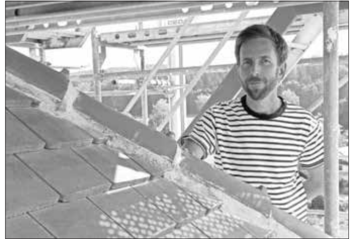
Architekt Christian Groß erläutert die Sanierungsarbeiten.
