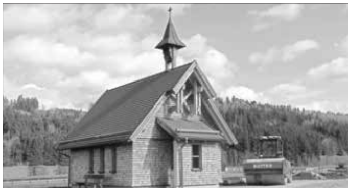
Die Kreuzkapelle im März 2024: Die Bauarbeiten sind weitgehend abgeschlossen.
